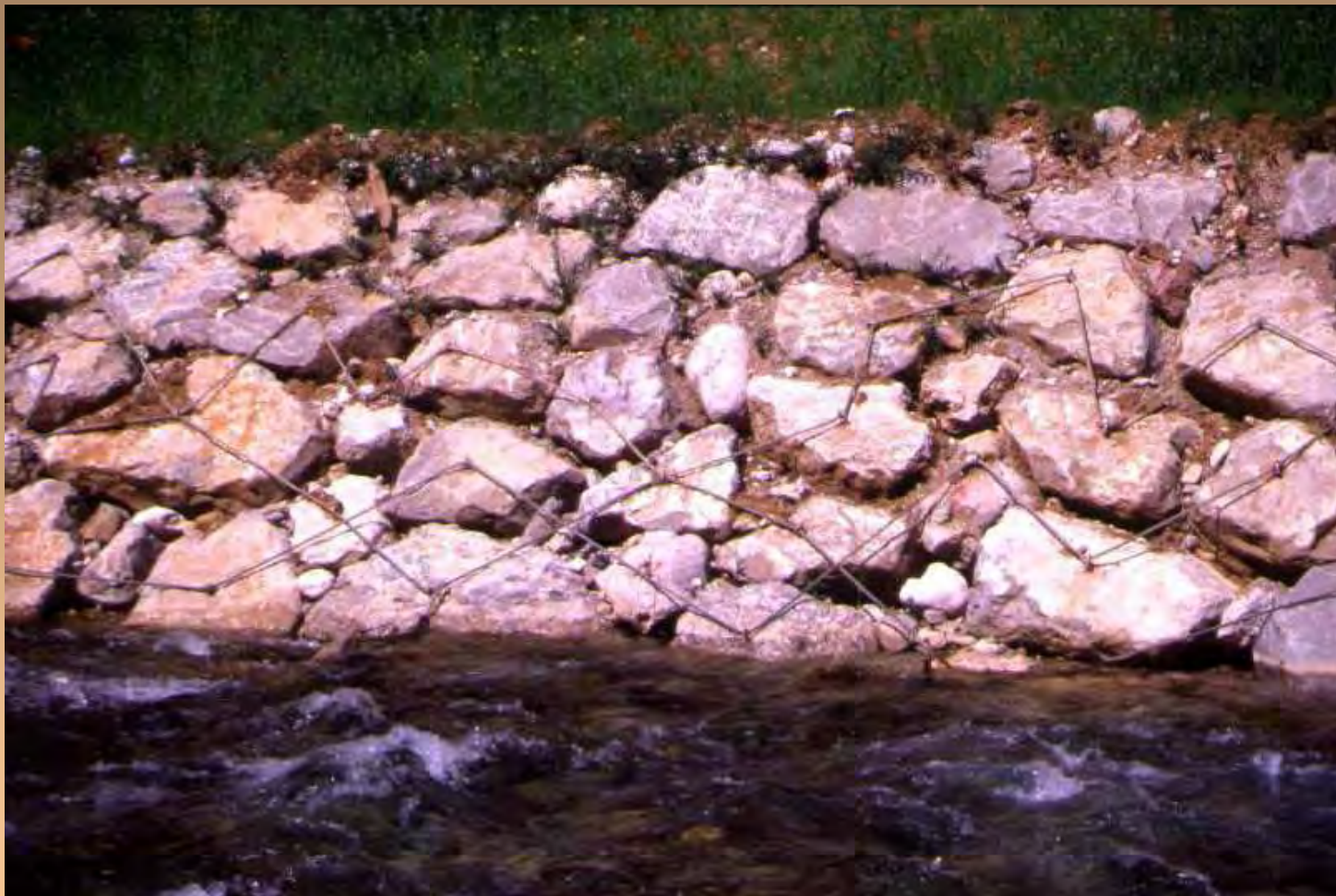
Corazzatura spondale in massi legati con funi d'acciaio. Rio Bianco Tarvisio Boscoverde (UD) - Foto G. Sauli
